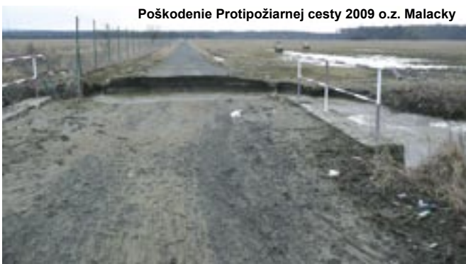
Poškodenie Protipožiarienej cesty 2009 o.z. Malacky
