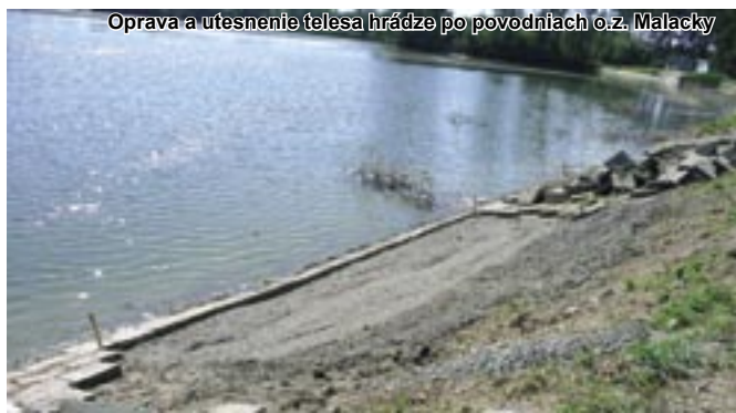
Oprava a utesnenie telesa hrádze po povodniach o.z. Malacky
