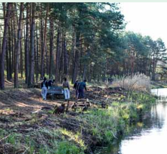
Bulkovec 2 úprava brehu
