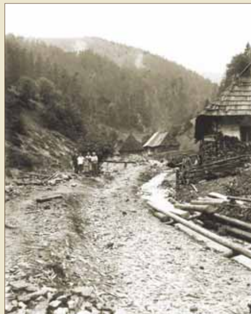
Stavebné práce na potoku Jelenec
