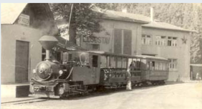
Na stanici v Liptovskom hrádku.
