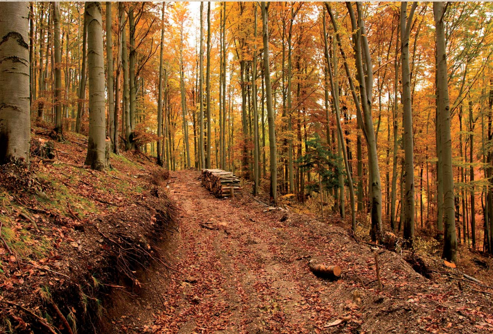
Obr. 25: Čerstvo zriadená približovacia linka buldozénom (V. Folkmar)
