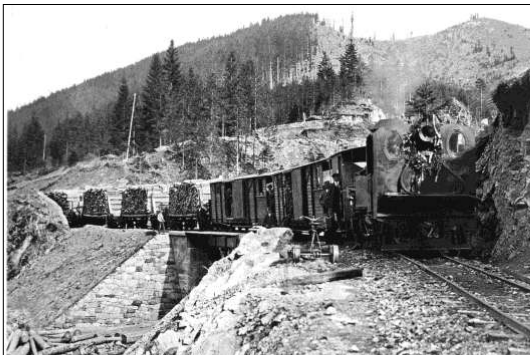
PLŽ Na moste na Č. Váhu – Benkove
