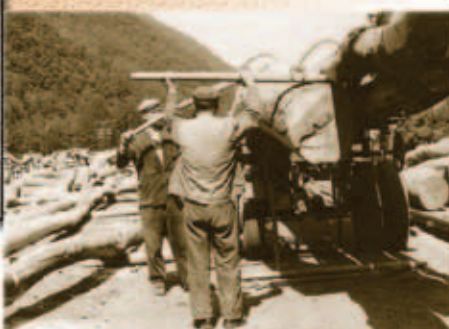
Ručné skladanie kmeňov na ES Brod
