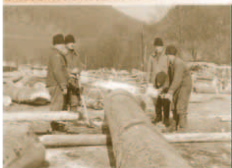
Manipulácia dreva dvojmužnou MP na ES Brod
