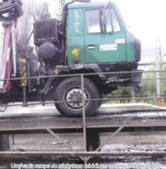
Umývacia rampa so záchytnou nádržou v areáli v Margecanoch.
