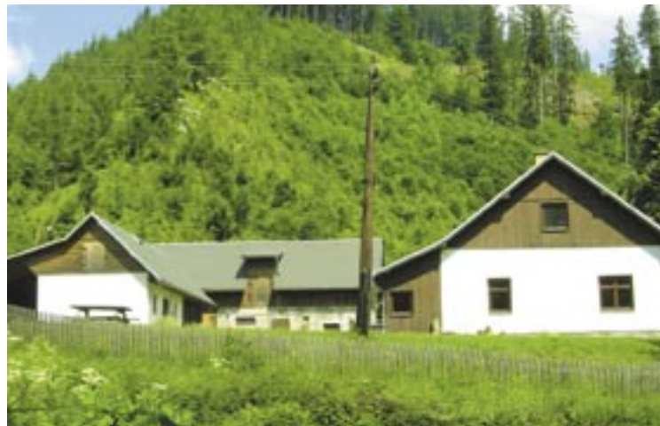
Zrekonštruovaná horáreň v lokalite Nižný Tajch
