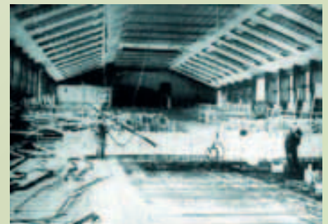
V rokoch 1943-48 postavená administratívna budova Dunajských veľtrhov bola neskôr prestavaná na známe PKO
