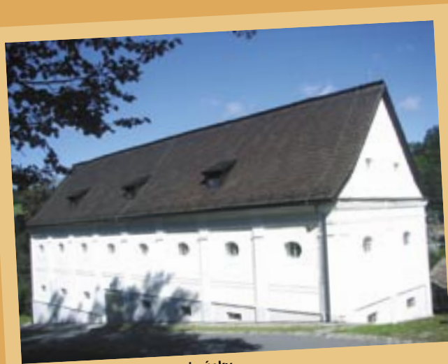
Budova rekonštruovanej sýpky
