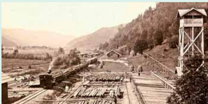
Lesní železnice, sklad dřeva, remíza pro lokomotivu a impregnační stanice ve Frassinu na Bukovině, r. 1910.
