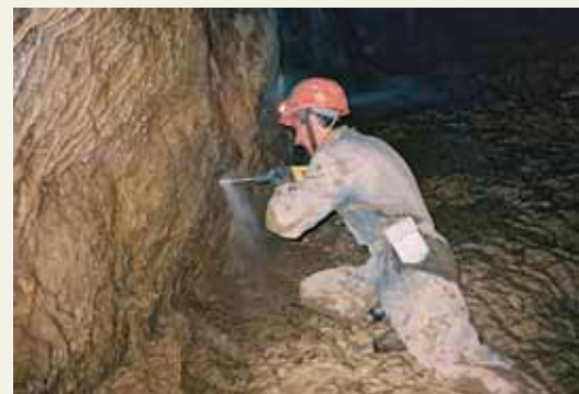
Vrtanie nitov na osadenie rebrika v jaskyni Večná robota
