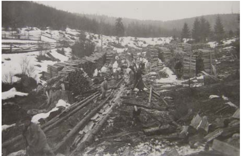
Na Čiernom Hrone sa v minulosti približovalo vyťažené drevo aj vďaka unikátnemu vodohospodárskemu systému. Na fotografii vhadzovanie paliva do vodného žlabu – flúdra, Krám, 1909, LDM Zvolen.
