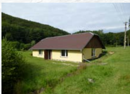
Obr. 4. Rozkrmovňa rýb vybudovaná v roku 2012
