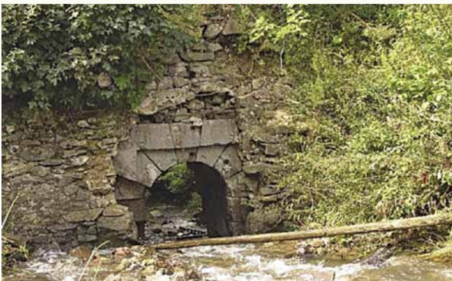
Čelo priepustu na hrádzi
