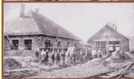
Výstavba úseku Mútne - Furandová v r. 1929
