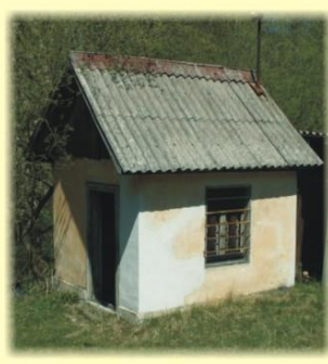
Železničná telefónna búdka
