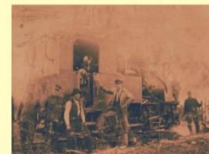
Srbskí vojnoví zajatci pri stavbe solivarskej lesnej železnice v roku 1917
