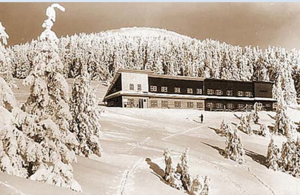
Chata na Veľkom Boku po rekonštrukcii v roku 1940. Archív P. Urbana
