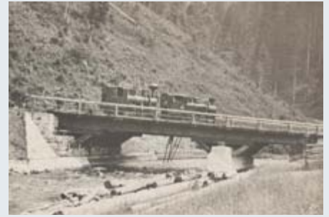
Stavba lesnej železnice Hronec – Sihla 1926, km 7,690 drevený most na Krámniskách
