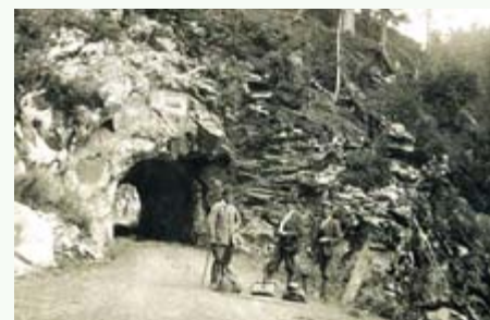
Tzv. Kelemenov tunel (riaditeľ ŠLS B. Bystrica) z r. 1928 (Predajná)
