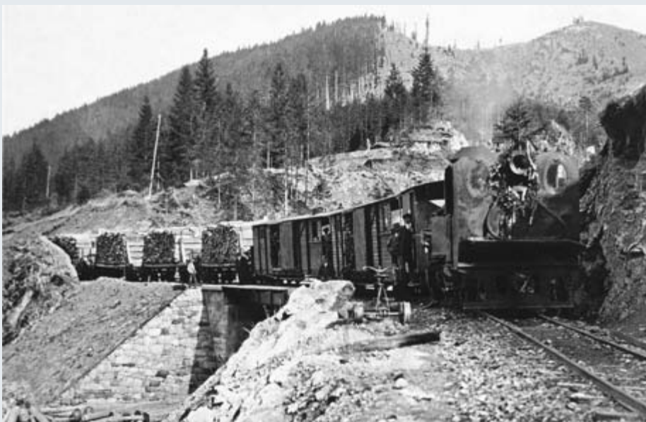
PLŽ Na moste na Č. Váhu – Benkove
