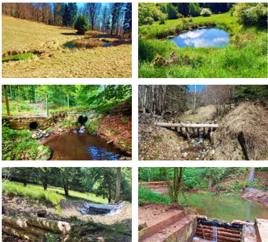
Obr. 2.6 Fotodokumentácia a praktické ukážky opatrení realizovaných na DO Duchonka – drevené a zemné hrádzky, jazierka, kalové jamy, hrable, cestné priepusty (Foto: Z. Sitková, D. Mikuš).
