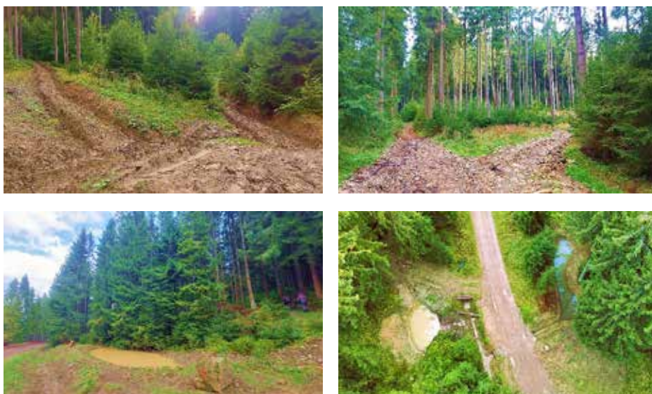
Obr. 2.17 Jedným z opatrení na flyši na DO Zákamenné je spevňovanie erodovaných lesných ciest drveným kameňom veľkej frakcie (hrubým makadamom), ktorý aspoň dočasne zvyšuje únosnosť cesty pri zaťažení, pri súčasnom zachovaní priesaku (hore). Ďalšími realizovanými vodozadržnými a protieróznymi opatreniami sú erózne ryhy a sedimentačné jamy (dole). (Foto: Z. Sitková, A. Gubka).
